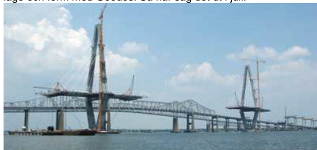
Nu börjar vägbanan t form. Fascinerande brobyggnadsteknik.
