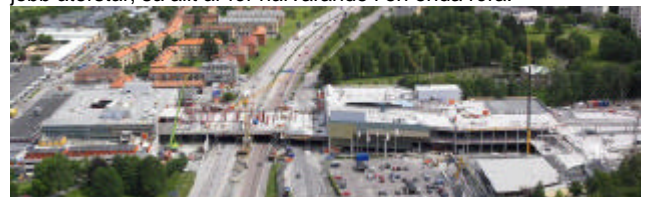
Byggarbetsplats. Vårt kontor syns längst uppe till vänster
